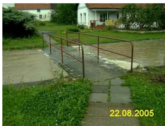
Most přes stoku v Češnovicích
